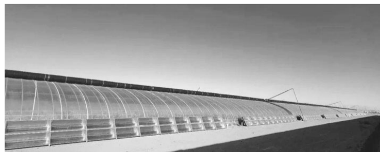
太阳能设施农牧业土壤跨季度储供热示范工程
